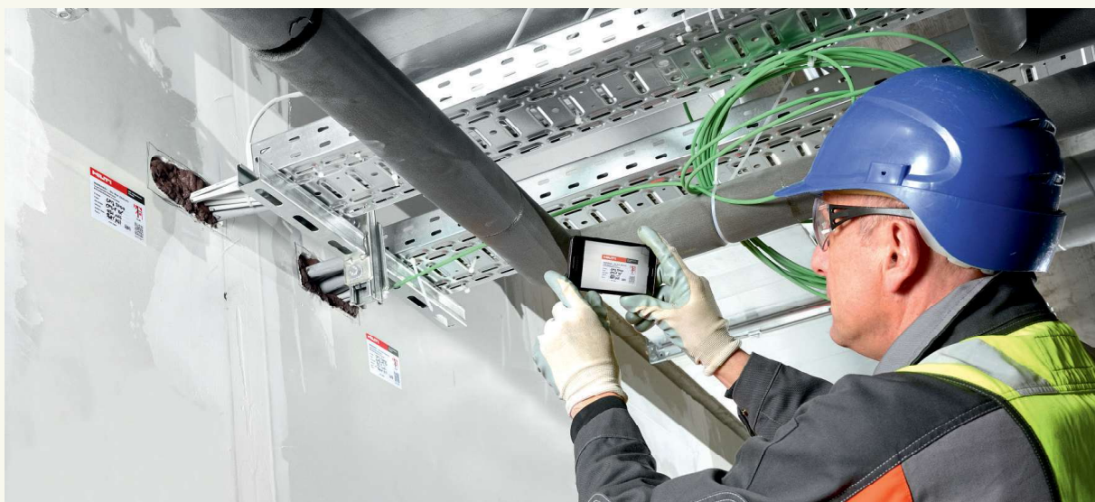
Figura 3 – Identificação e registro das selagens
