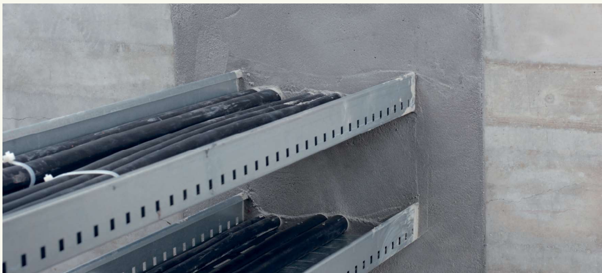
Figura 2 – Selagem de leitos em parede externa
