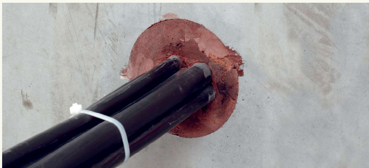
Figura 1 – Selagem de passagem de cabos em parede
