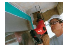
Martelete TE 7 Fixação em concreto Kwik HUS
